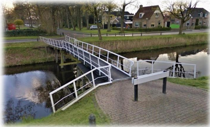
Fiets – en loopbrug Oosterwolde (inmiddels vervangen)
